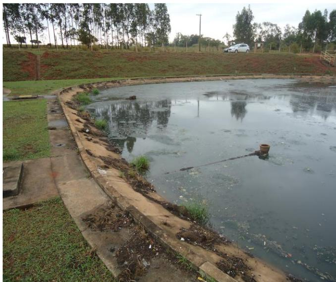
Foto 6.1 – Vista geral da presença de sobrenadante na lagoa anaeróbia
