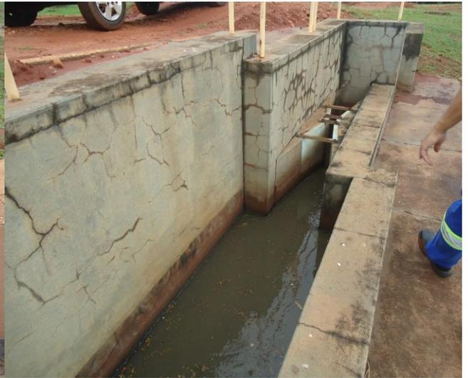
**Foto 3.15 – Desarenador + Calha Parshall**
